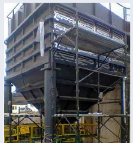
Ochrona zbiornika przed zamarzaniem, Bułgaria
