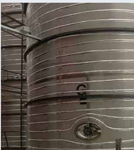
Ogrzewanie technologiczne zbiorników na płyn, Rumunia
