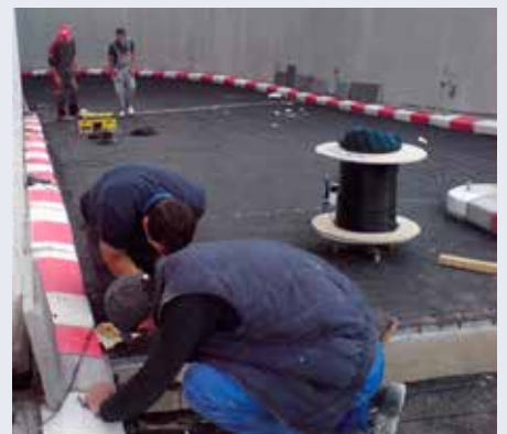
Wjazd do garażu podziemnego, Ljubljana, Słowenia
